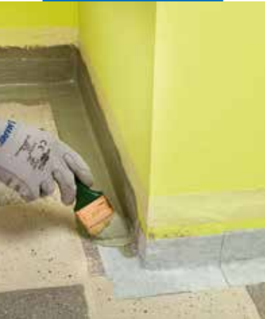
Mapeband SA bedolgozása esztrichre
