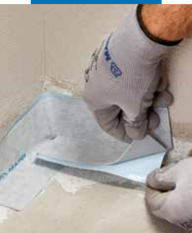
Mapeband SA bedolgozása sarokba
