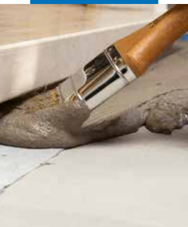
Mapeband SA bedolgozása nehezen hozzáférhető helyekre, mint pl. lépcső alá
