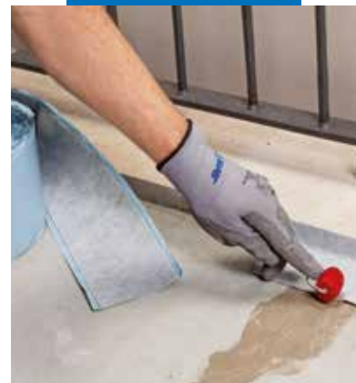
Mapeband SA bedolgozása élekekhez
